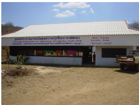
正面から見た開発支援センター
