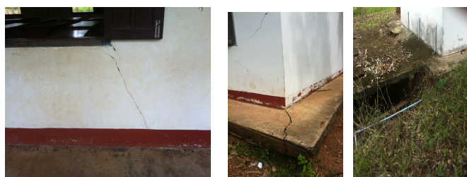
教室の壁(左) 基礎部分のひび割れ(中央) トイレの処理タンク(右)
