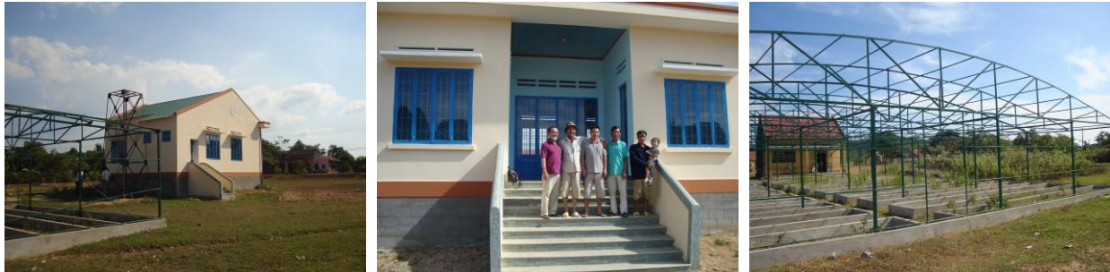
(左から完成した農業支援センター、その入り口で村人と(左:新田)、グリーンハウスの鉄骨)
