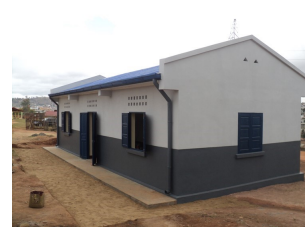
完成した図書館
