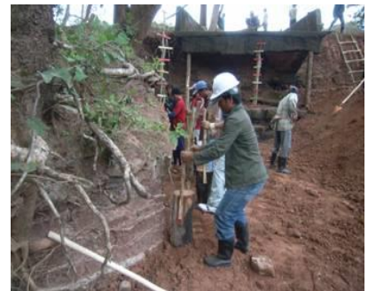
たこ締めによる土の締め固め状況
