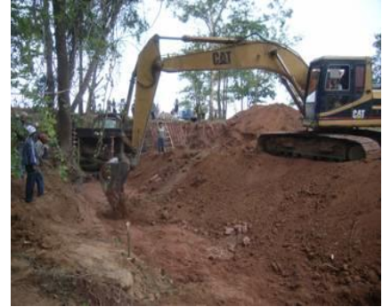
ローチョックによる作業
